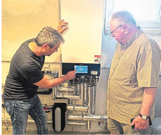
Alfred Thaller (re.) aus Deutsch-Haslau tauschte nach 28 Jahren seine alte Ölheizung gegen eine klimaschonende Luftwärmepumpe. Szegner-Techniker Benjamin Dreml erklärt die Bedienung der neuen Anlage
